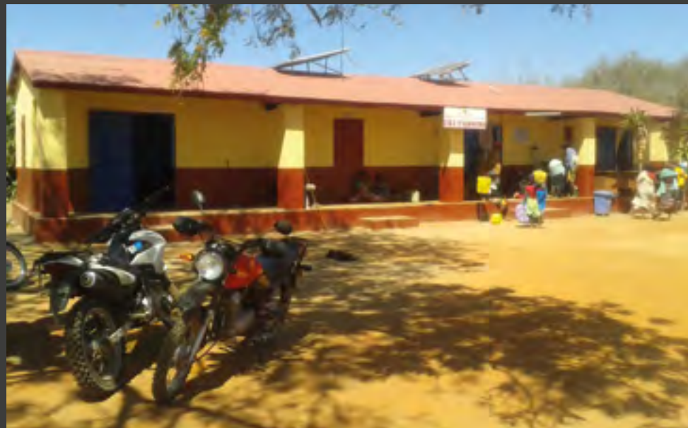
Das Gesundheitszentrum in Agnavoha nach der Renovierung
