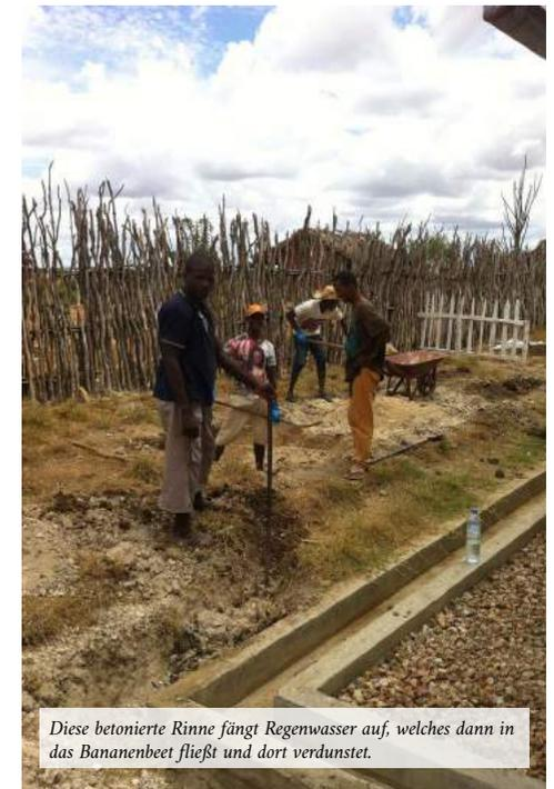
Diese betonierte Rinne fängt Regenwasser auf, welches dann in das Bananenbeet fließt und dort verdunstet.
