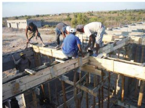
Arbeiter errichten Stahlbetonträger für das Dach des Stationsgebäudes.
