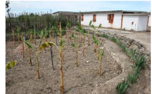
Für dieses Verdunstungsbeet wurde eine Grube von 260m<sup>3</sup> von Hand gegraben, mit Lehm ausgekleidet, mit Kies gefüllt und mit Bananen bepflanzt.
