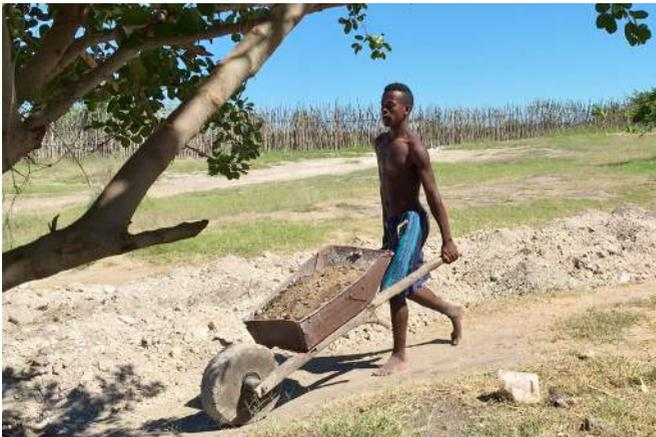
Die Erde von 260m<sup>3</sup> Aushub des Verdunstungsbeetes wird in Schubkarren transportiert. Das Rad ist ein Mühlstein.
