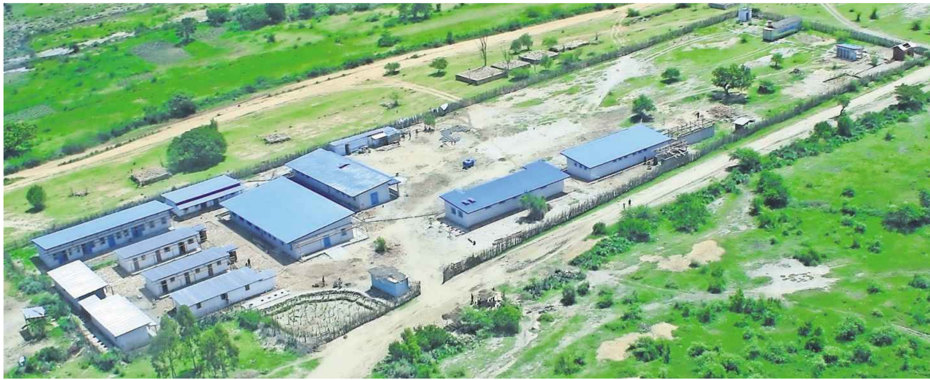
Das neue Krankenhaus „Hopitaly Zoara“ in Fotadrevo (Madagaskar), inmitten der Savanne, ist nunmehr fertiggestellt.
